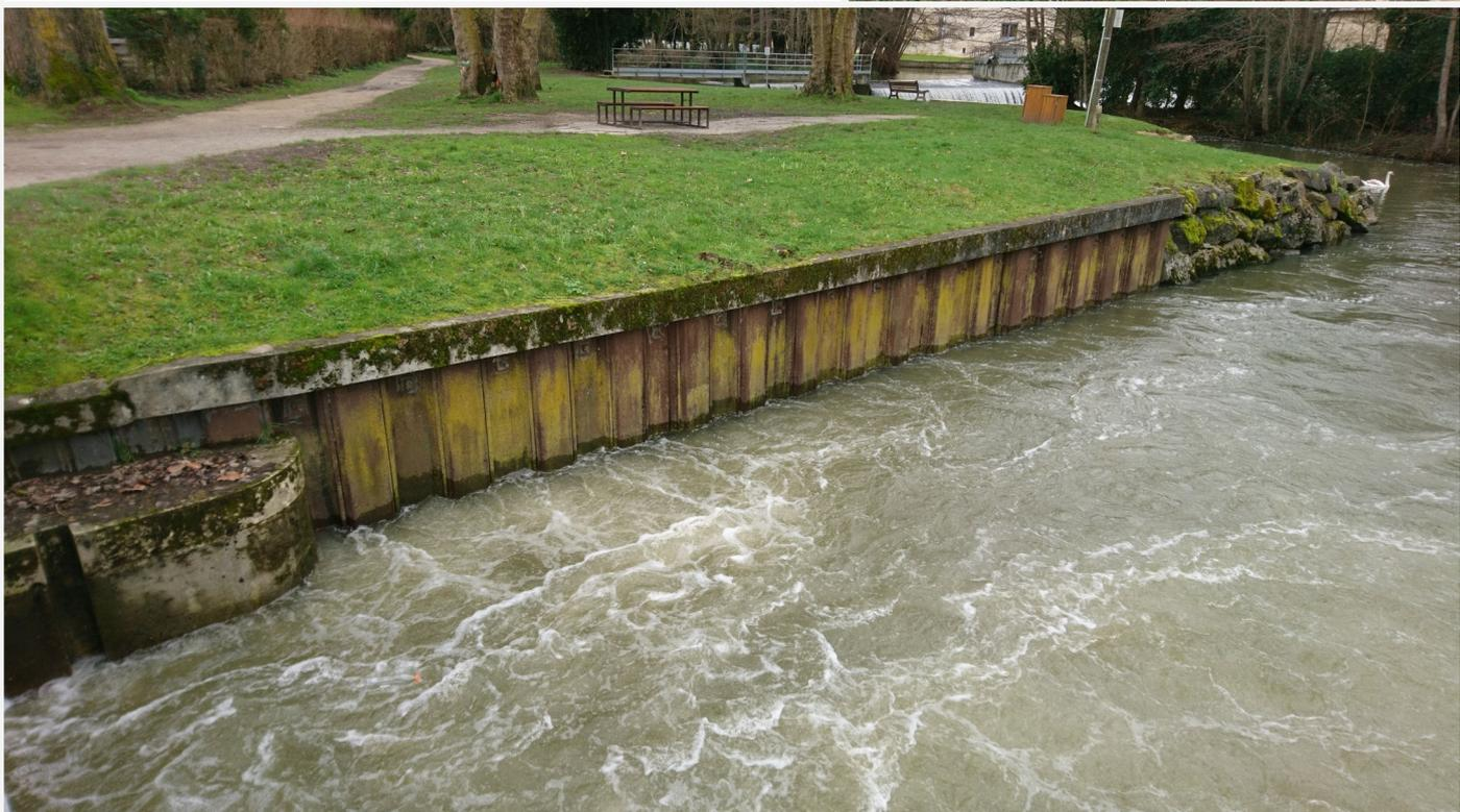
En rive droite de la Sèvre Niortaise, en face de l'île de la Belle-Étoile, un mur en béton, pierres et traverses de chemin de fer a été érigé dans la berge. L'ouvrage est identique à celui construit en aval immédiat de l'écluse de Comporté. En plusieurs points, il est entrecoupé d'escalier descendant à la rivière.
