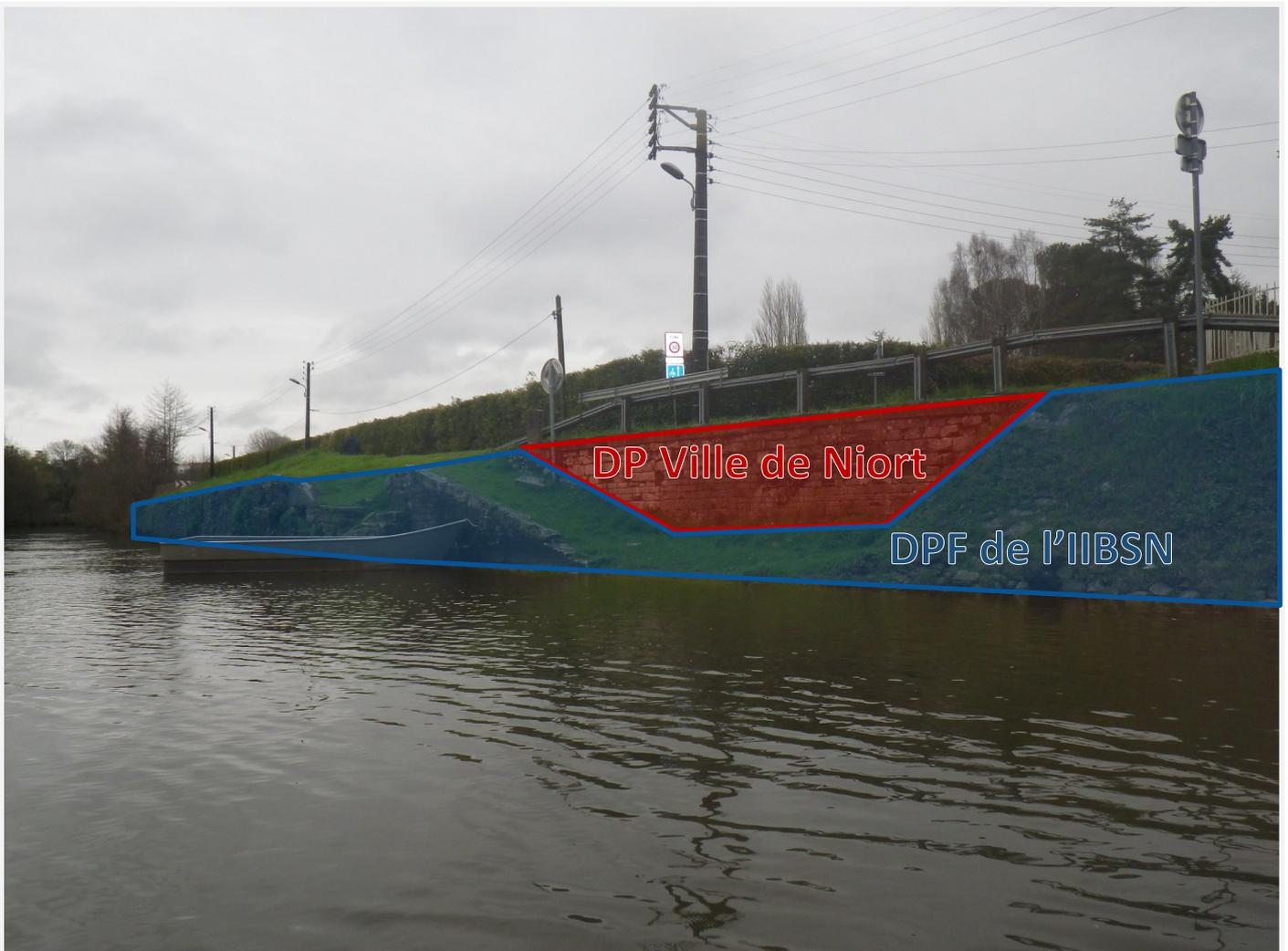
La cale est prolongée vers l'aval par un mur constitué de pierres, de béton et de traverse de chemin de fer. Cet ouvrage faisant office de protection de berge est intégré au Domaine Public Fluvial.
